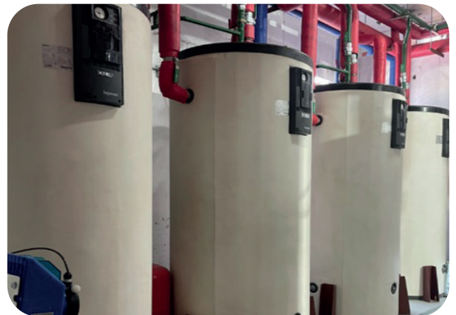
Batería de inter-acumuladores Gesiser Inox de doble pared
